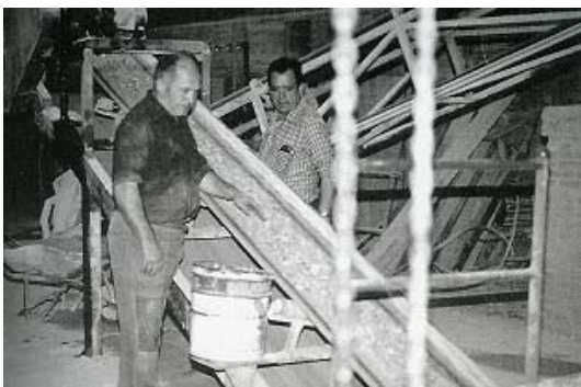
Cinta transportadora traslladant mineral
