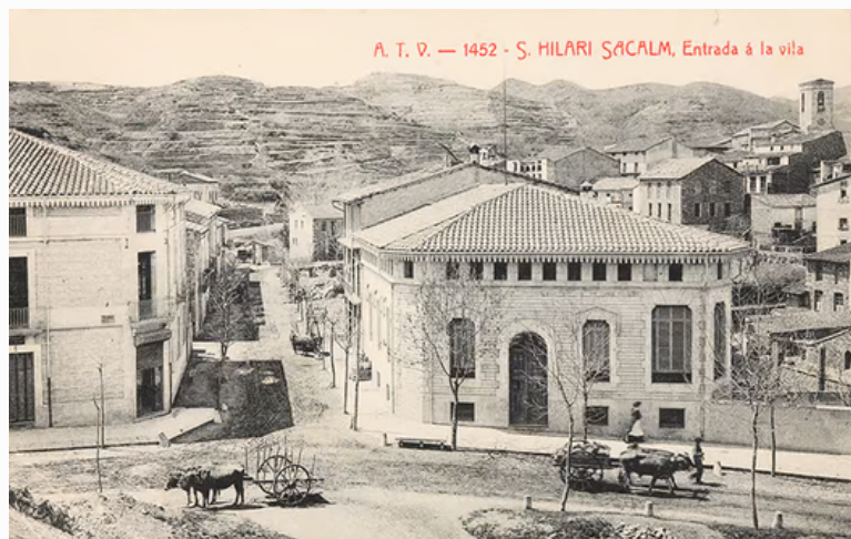
L'edifici de Can Puntí, on ara hi ha Can Barnet, on van caure bombes el 31 de gener del 1939 (Arxiu Municipal de Sant Hilari Sacalm)
