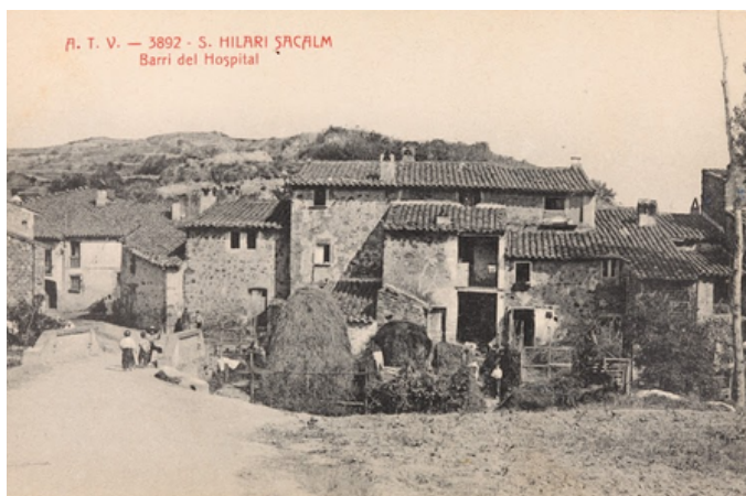
Barri de l'Hospital als anys 20. Es construeixen cases on hi havia hagut l'antic hospital i, a l'esquerra de la imatge, hi ha el pont sobre la riera de Vallicrosa i l'antic escorxador (Arxiu Municipal de Sant Hilari)
