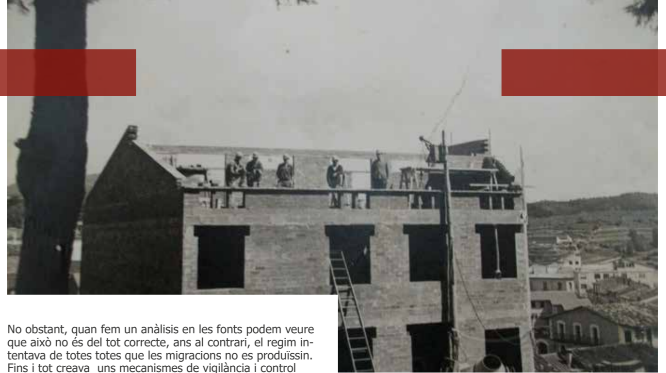
Foto cedida per Josefa Diaz. Ampliació de l'hostal Verdolet. Alguns nous-vinguts com Jose Rojas (al centre) varen treballar a la construcció que també era un sector que va necessitar mà d'obra immigrant. Any 1976
