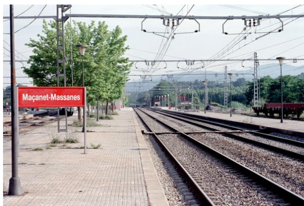
Imatge de l'estació de tren de Maçanet-Massanes
