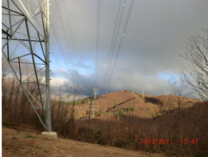
Vista de la línia de la M.A.T.
