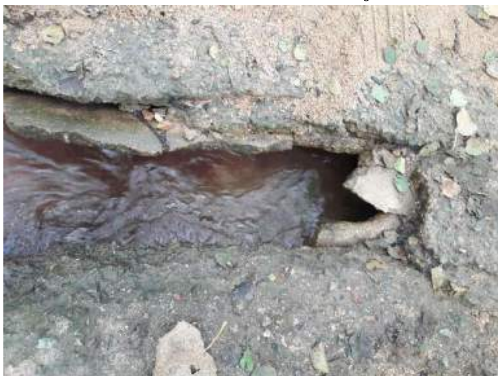
Tub de ciment de poc diàmetre per on la riera creua la carretera, vora el pla de la Civadora
