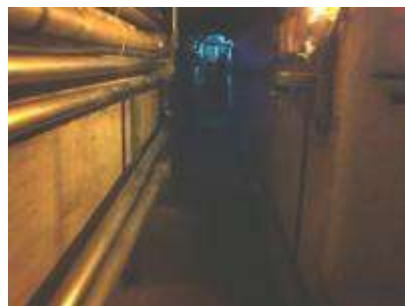
Mines. Conducció de l'aigua des dels pous a la planta embotelladora
