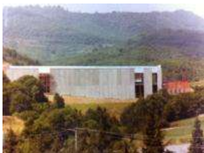
Construcció de la nau al costat de la planta embotelladora als anys 60
