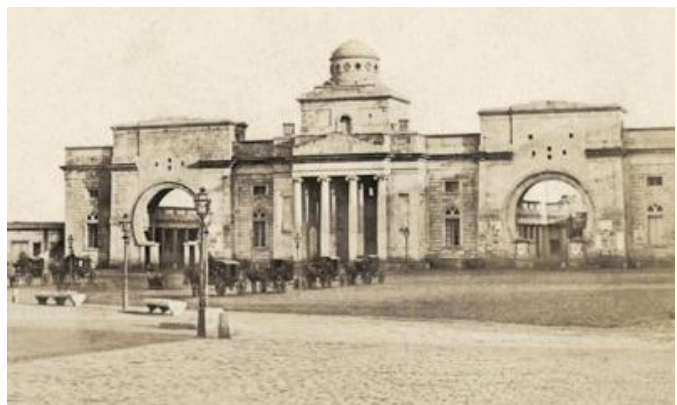
Portal del Mar
