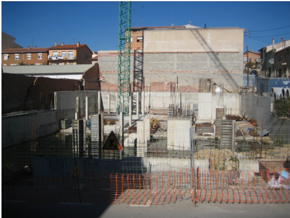
Fotografia d'una construcció de pisos al Carrer Piscina.
