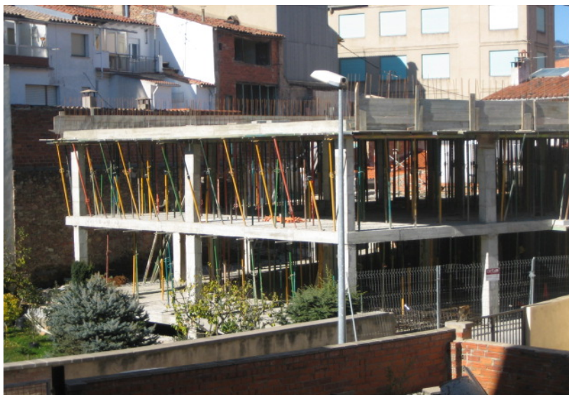
Construcció de pisos al carrer Hospital.
