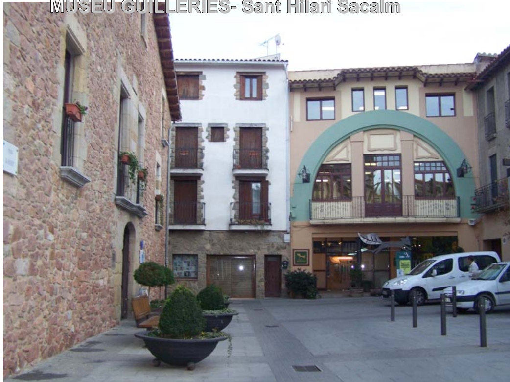
Edifici de la Cooperativa i can Rovira
